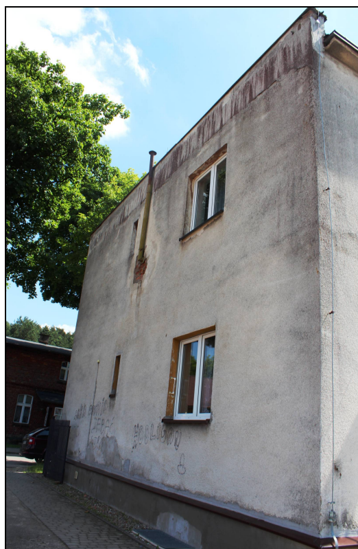
Fot. nr 4. Widok elewacji północno-zachodniej
