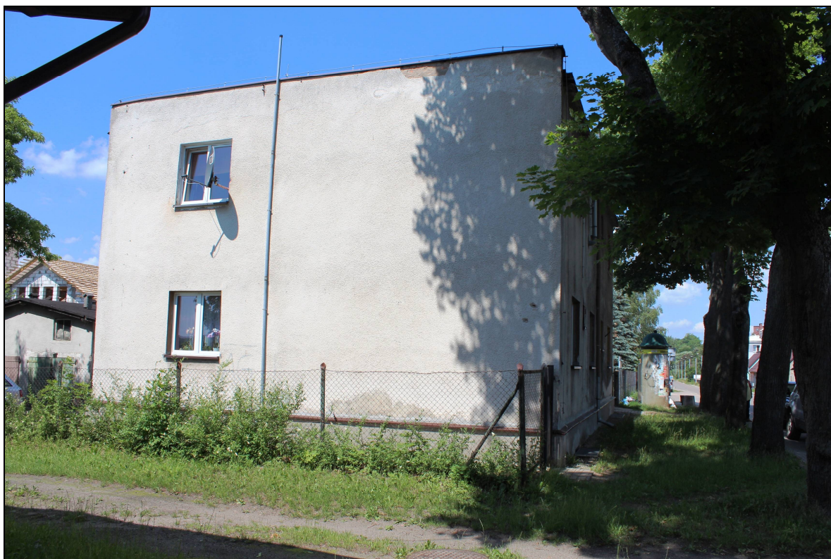
Fot. nr 3. Widok elewacji południowo-wschodniej
