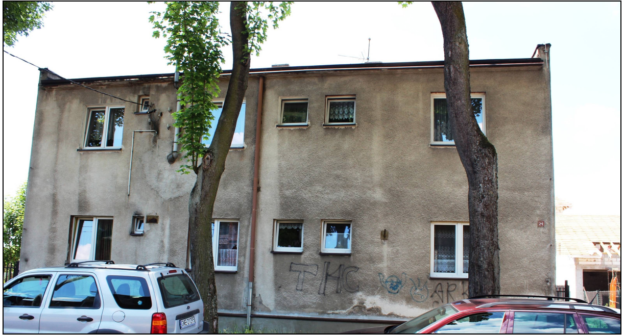
Fot. nr 1. Widok elewacji północno-wschodniej
