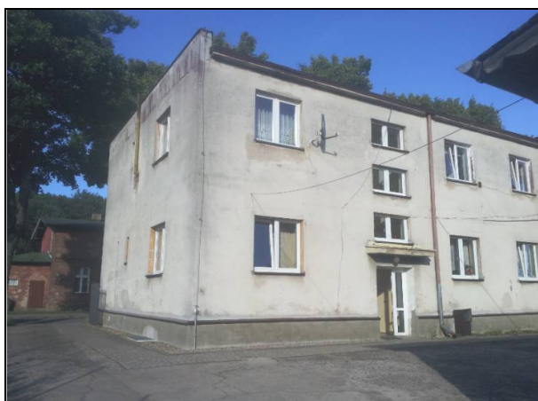
Rysunek 2.8. Widok budynku od podwórza
