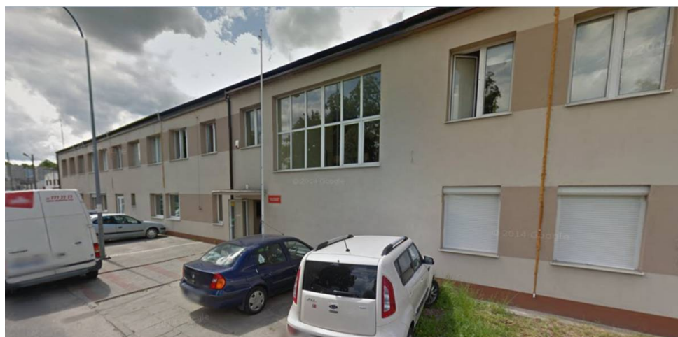
Rysunek 2.5. Widok elewacji wschodniej – część południowa
