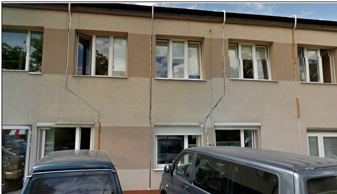
Fot. 8.1. Widok elewacji wschodniej z okresu przeprowadzania montażu instalacji klimatyzacyjnych (czerwiec 2013 r.)
