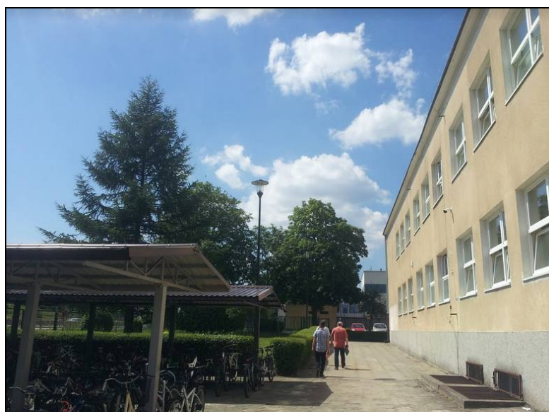
Rysunek 2.5. Widok elewacji szkoły od strony ulicy Wejherowskiej
