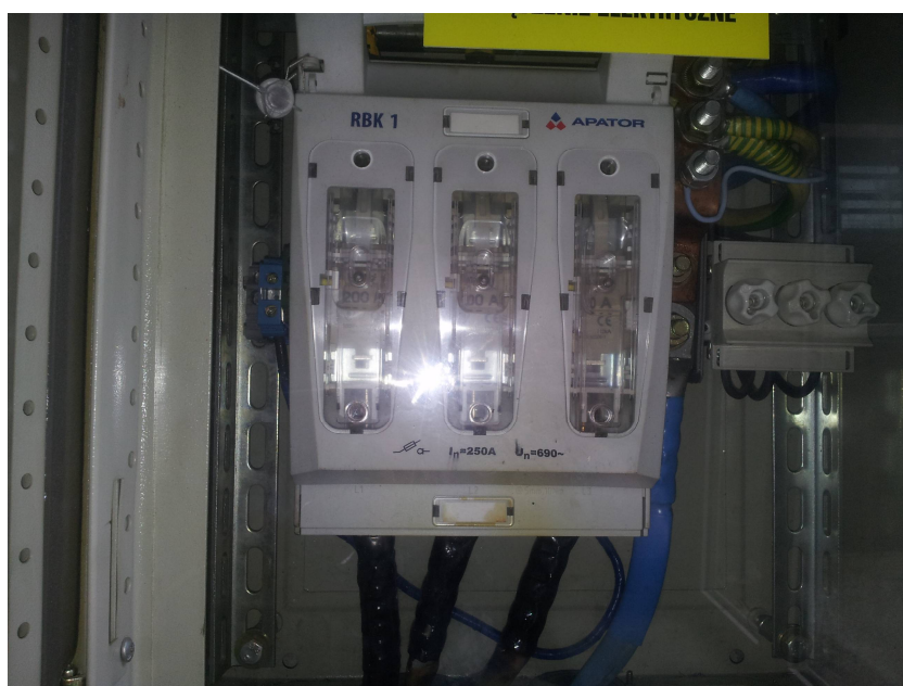
Fot. 4. Widok wyłącznika głównego (rozłącznika bezpiecznikowego)
