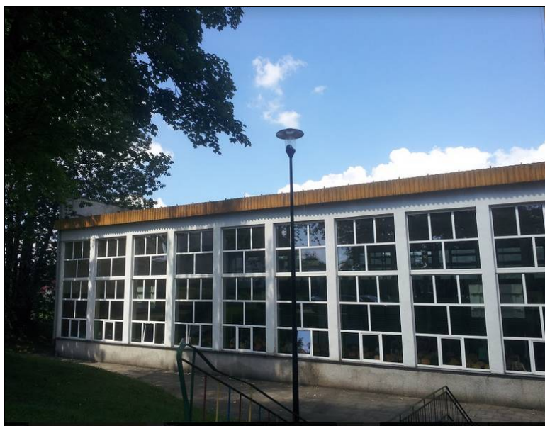
Rysunek 2.6. Drzewa zaciniające budynek sali gimnastycznej
