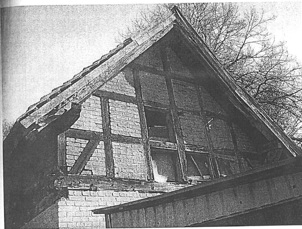
Rysunek 4. Widok uszkodzeń elewacji bocznej
