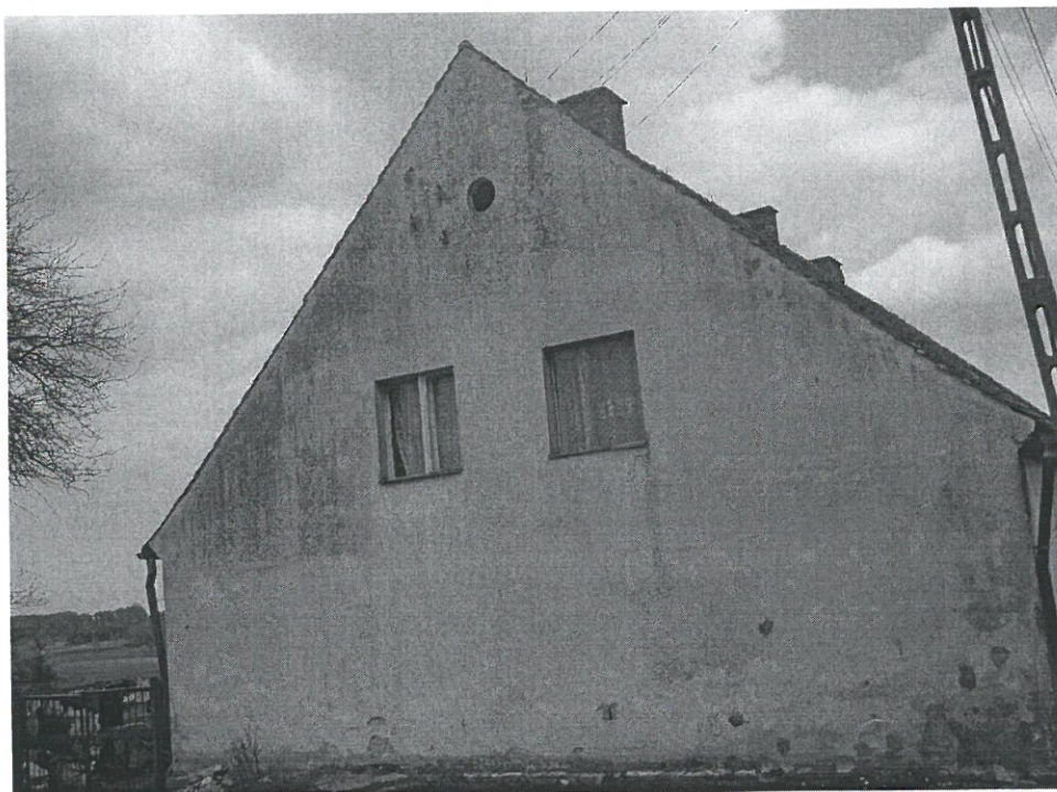
Rysunek 4. Widok drugiej elewacji bocznej
