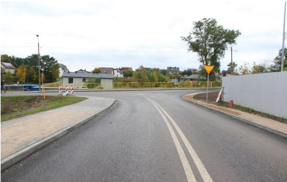
Budowa oraz przebudowa dróg gminnych: ul. Klimka, ul. Równej, ul. Handlowej w Gościnnie
