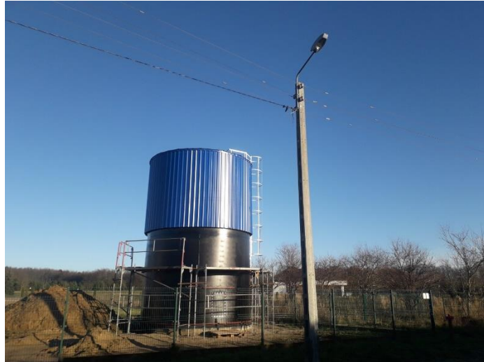
Budowa zbiornika retencyjnego wody uzdatnionej
