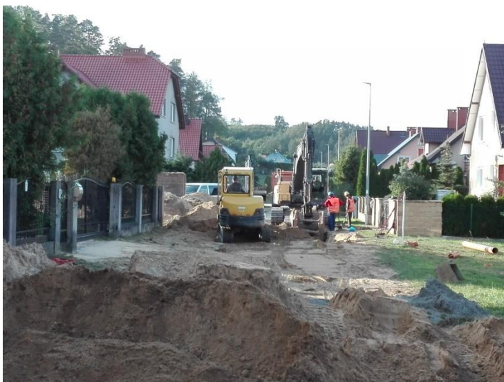
Budowa kanalizacji sanitarnej i sieci wodociągowej w Orlu
