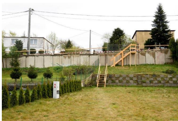
Remont muru oporowego w Gościcinie w ciągu ul. Osiedlowej
