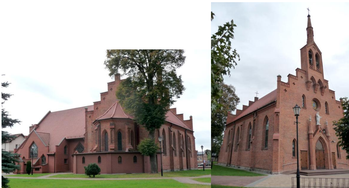
Zdjęcia nr 2, 3. Kościół parafialny pw. Wniebowzięcia NMP, ul. Główna w Bolszewie
