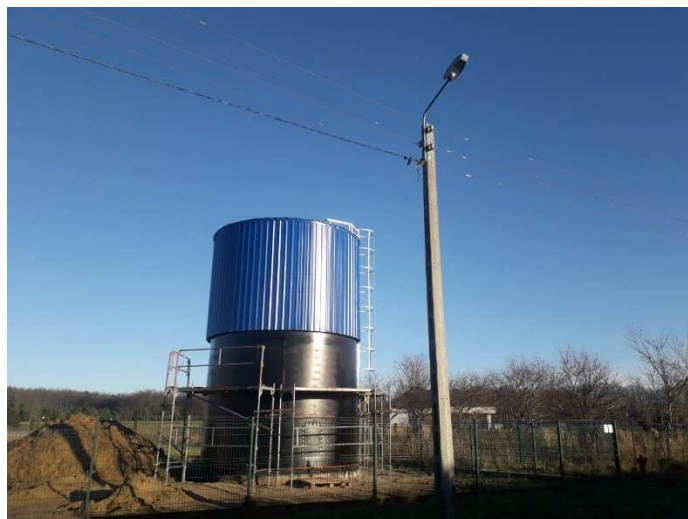
Budowa zbiornika retencyjnego wody uzdatnionej
