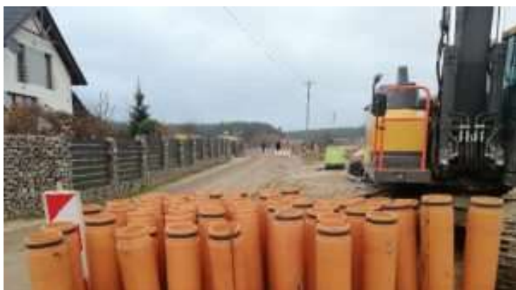
Budowa kanalizacji sanitarnej i sieci wodociągowej w Orlu
