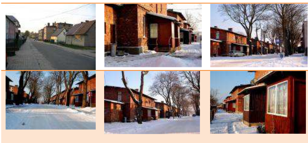
Zabytkowe domy mieszkalne z początku XX w. przy ulicy Drzewiarza
