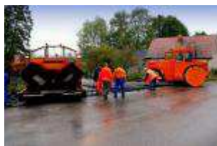
Remont nawierzchni ul. Łąkowej
